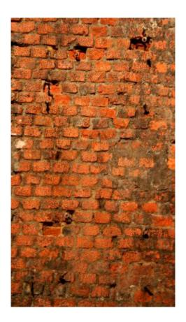
O revestimento da galeria tem uma espessura média indicada no projecto original igual a 0,80 m, sendo de alvenaria de tijolo na abóbada e de alvenaria de tijolo ou de pedra nos hasteais.
