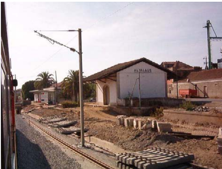
Cais coberto da estação de Alvalade. Foto de Miguel Gregório
