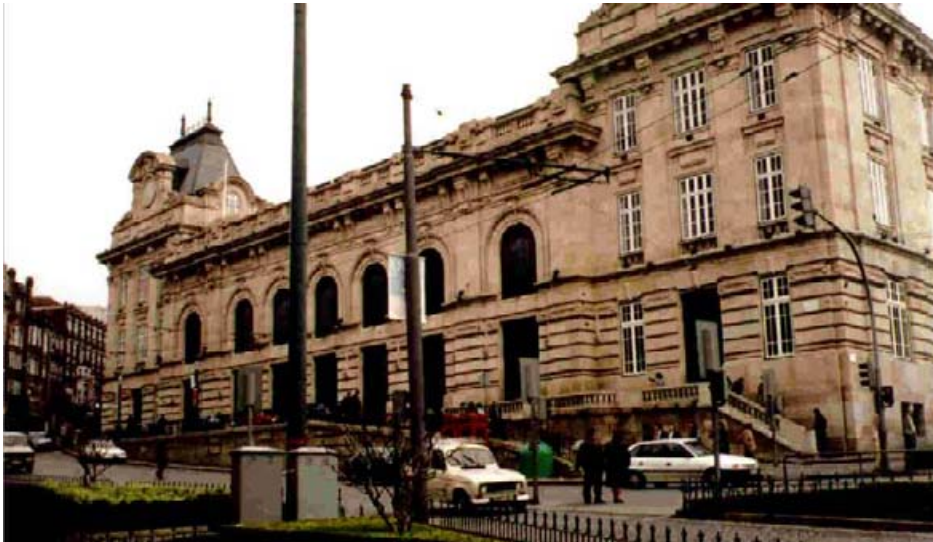
Fachada principal da estação de São Bento. Foto de Manuel Luna
