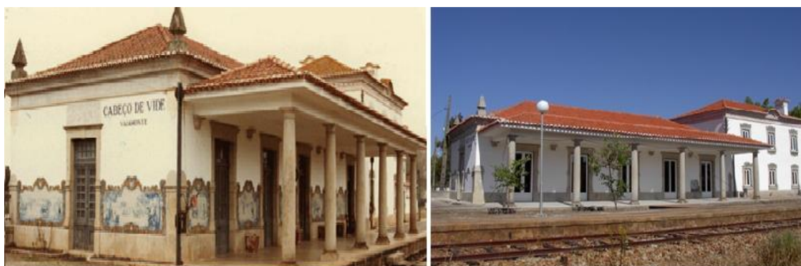
Figura 2-24: Estação Cabeço de Vide antes da reabilitação (à esquerda) (Fonte: Arquivo histórico da CP); Estação convertida em estalagem (à direita) (Fonte: [Web 19] ).
