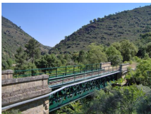
Figura 4-18: Ponte da Cabreira (Foto do autor, junho de 2011).
