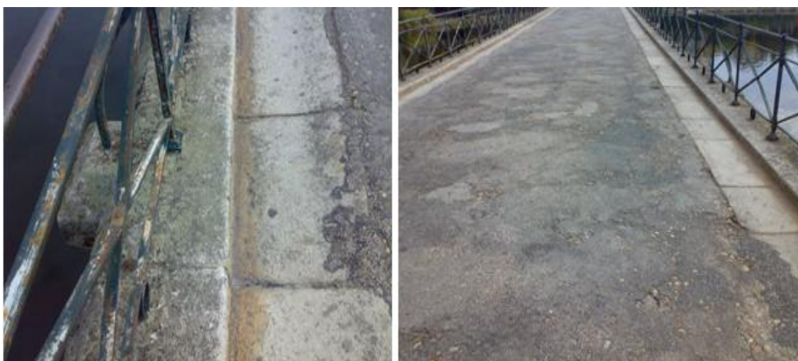
Figura 6-29: Passeio (à esquerda) e tabuleiro (à direita) da ponte de Mirandela (Fotos do autor, outubro de 2011).
