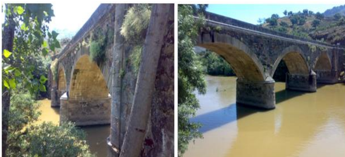
Figura 6-20: Ponte de Vilarinho das Azenhas (Fotos do autor, junho de 2011).
