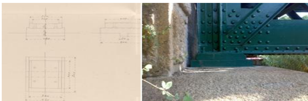
Figura 5-6: Aparelho de apoio que permite dilatação da ponte de Meireles/Cachão (Fonte: REFER e Foto do autor, outubro de 2011).
