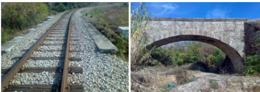
Figura 5-20: Ponte de Ribeira da Carvalha/Frechas (Fotos do autor, outubro de 2011).
