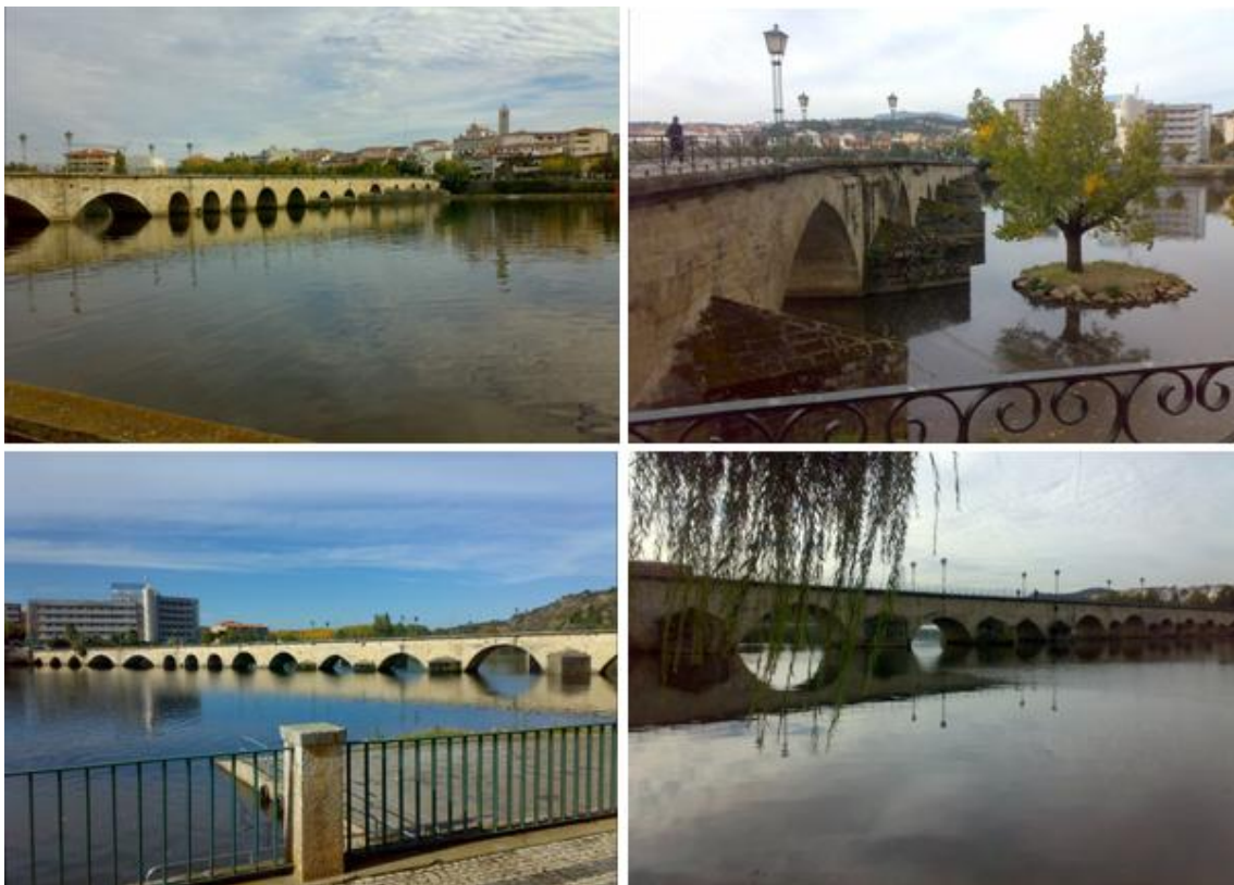
Figura 6-23: Ponte Medieval de Mirandela (Fotos do autor, outubro de 2011).
