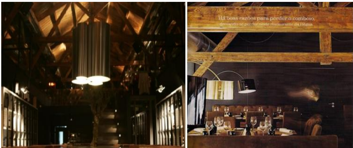
Figura 2-29: Estrutura do telhado em madeira (Fonte: [Web 22] ).
