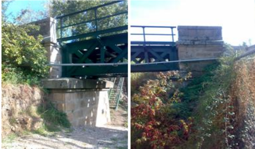
Figura 5-8: Encontros da ponte de Meireles/Cachão, do lado do Tua, à esquerda, e, do lado de Mirandela, à direita (Fotos do autor, outubro de 2011).
