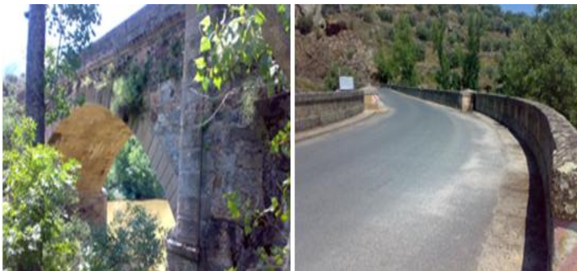
Figura 6-21: Encontro do lado de Vilarinho das Azenhas, à esquerda; vista do tabuleiro da ponte de Vilarinho das Azenhas da margem esquerda do rio Tua (Fotos do autor, junho de 2011).
