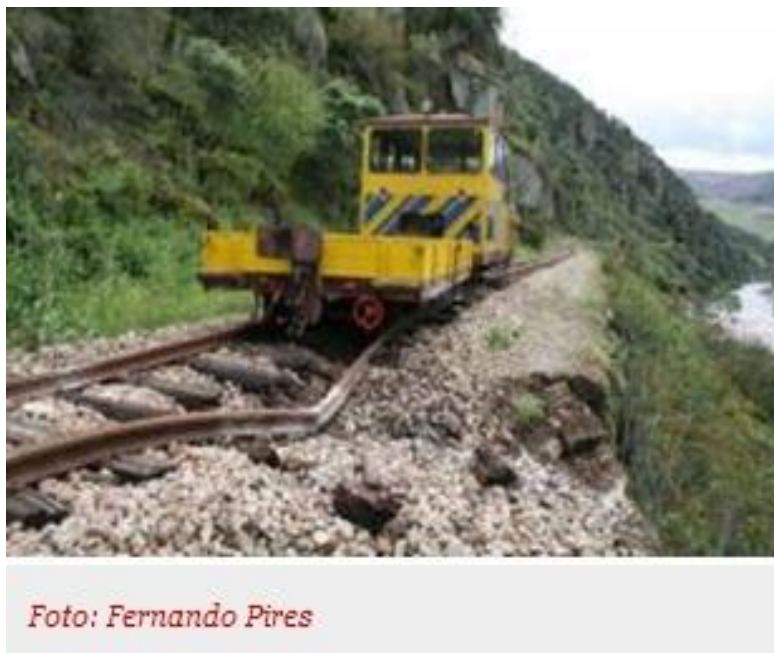
Figura 3-15: Acidente caudado por desabamento de terras (Fonte: [ Web 13 ]).
