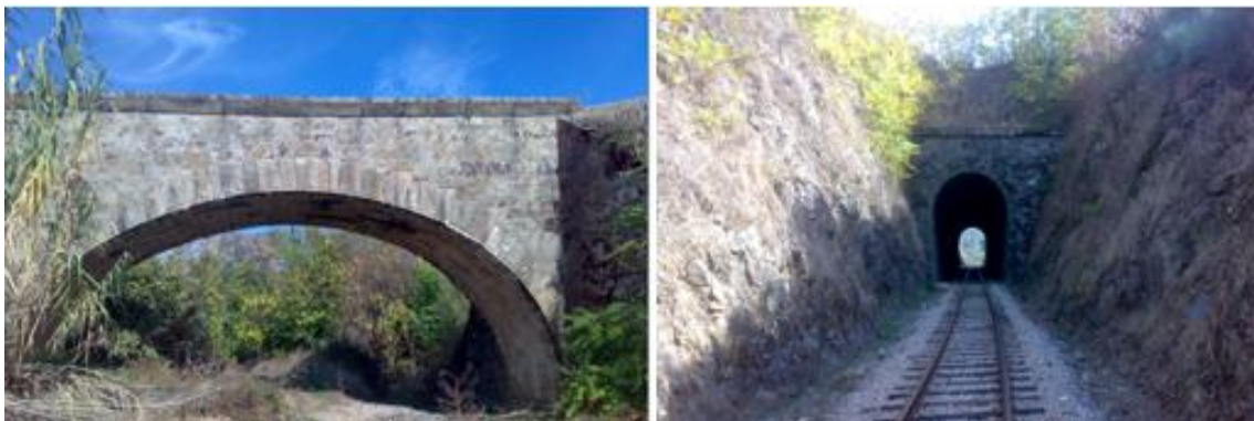
Figura 4-24: Ponte sobre a Ribeira da Carvalha; Túnel de Frechas (Fotos do autor, outubro de 2011).
