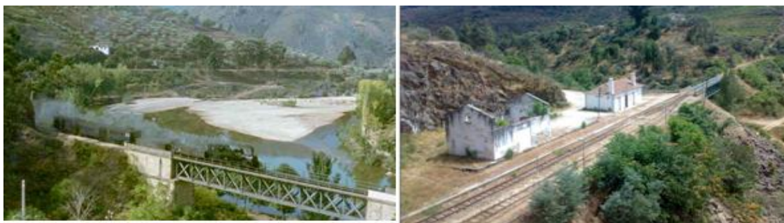
Figura 4-19: Ponte de Vieiro com o comboio a vapor, foto de 24/9/1972 (Fonte: [Web 44] ), à esquerda. Vista da Estação de Abreiro, bem como da Ponte Ferroviária de Vieiro, foto tirada de cima da ponte Rodoviária de Abreiro (Foto do autor, julho de 2011).
