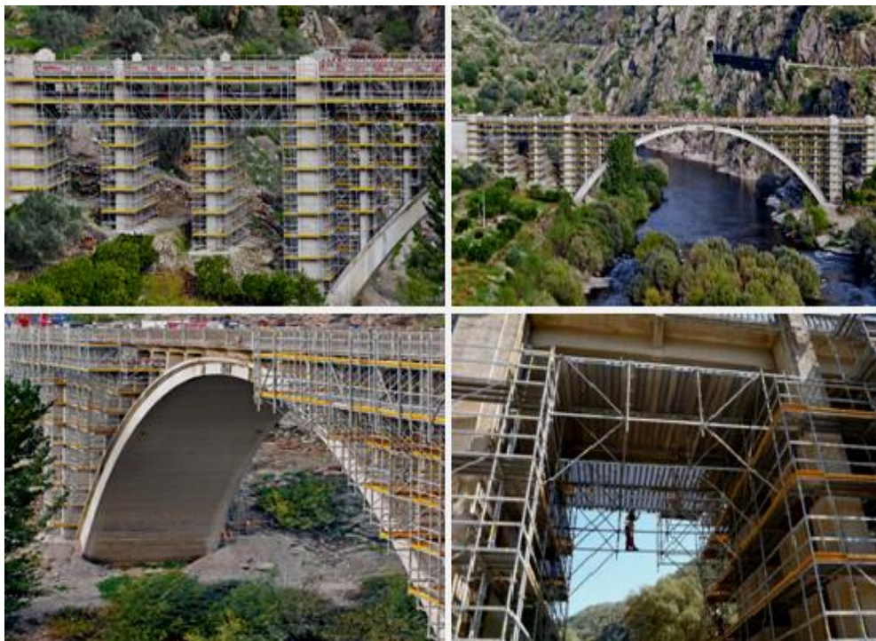
Figura 6-16: Obras de reabilitação da ponte do Tua (Fonte: [Web 48]).
