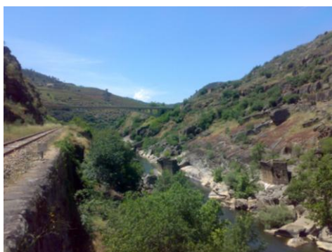
Figura 4-20: Ruínas da Antiga Ponte de Abreiro e nova ponte de Abreiro ao fundo. (Foto do autor, julho de 2011).
