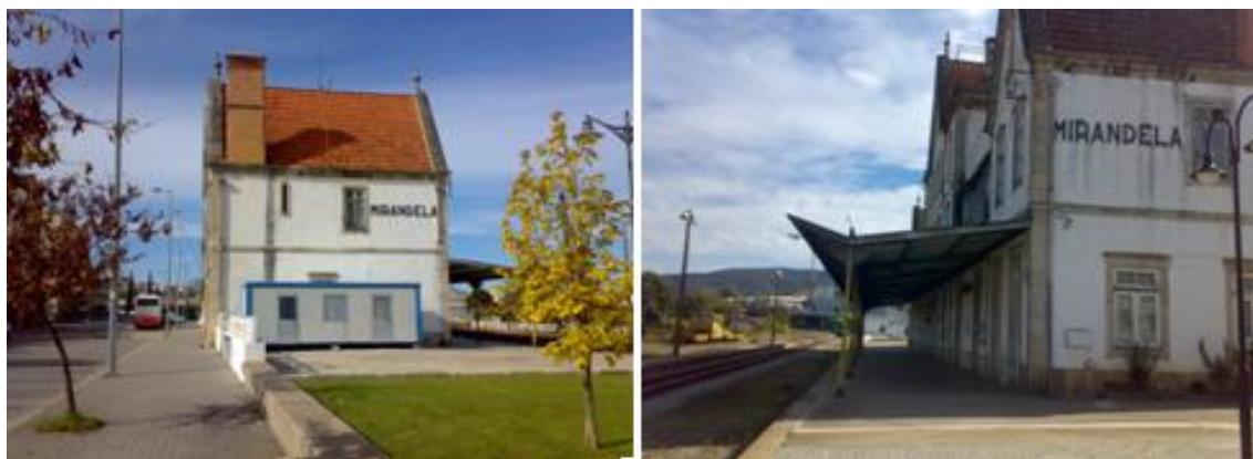
Figura 4-26: Estação ferroviária de Mirandela (Fotos do autor, outubro de 2011).
