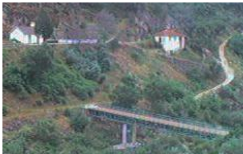
Figura 6-17: Antiga ponte metálica de Amieiro (Fonte: Web 45 ).
