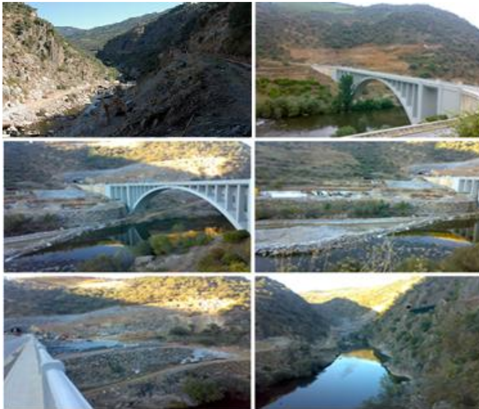
Figura 3-23: Obras para a construção da Barragem Foz Tua (Fotos do autor, maio e outubro de 2011).
