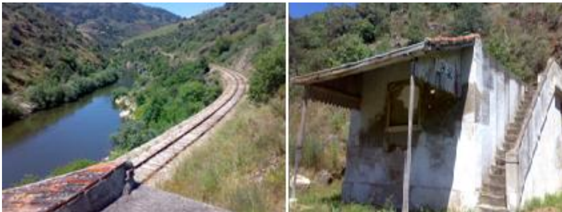
Figura 4-15: Apeadeiro de Tralhão, à esquerda; Vista do telhado do apeadeiro de Tralhão, à direita (Fotos do autor, julho de 2011).
